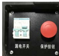
图 11 漏电开关与保护按钮
