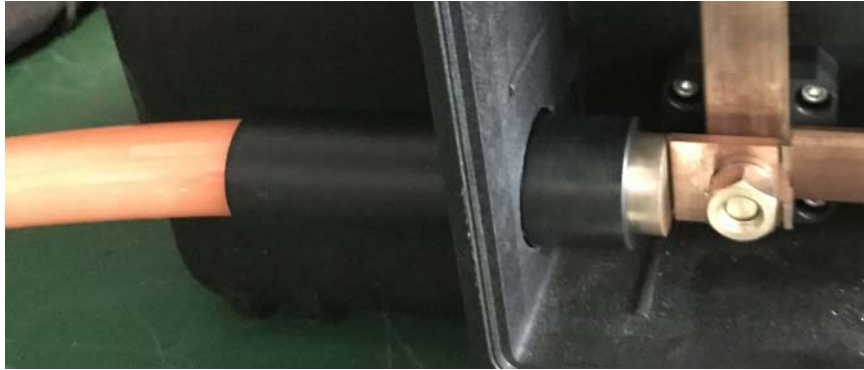
连接电缆的连接头注意用扳手旋紧
